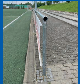
Scharfkantige Aufhängungen für Werbeanlagen stellen ein hohes Verletzungsrisiko dar.
